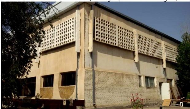
Фото №1. Общий вид здания библиотеки до реконструкции
