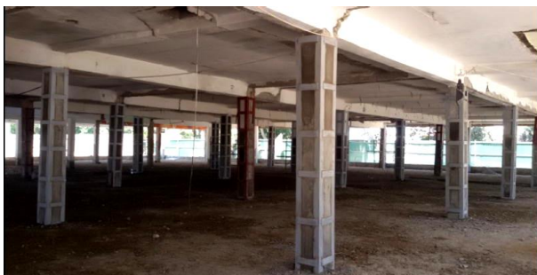
Фото №5. Общий вид конструкций усиленных колонн, существующих ригелей и плит перекрытия 1-этажа здания
