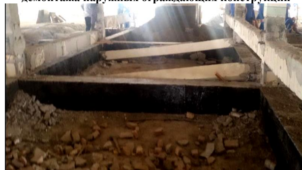
Фото №4. Общий вид конструкций перекрытия подвала здания после демонтажа плит и ненесущих ригелей перекрытия подвала, изготовления монолитных ж/б балок в плоскости колонн на 70 см ниже отметки существующего пола 1-этажа
